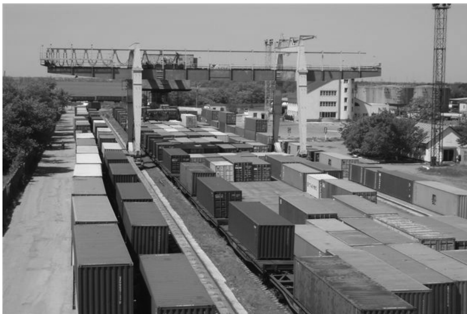
Rys. 2. Kompleks przeładunkowy na stacji Odessa-Liski
