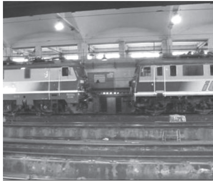
Rys. 1. Widok ogólny hali lokomotywowni Olszynka Grochowska [fot. Ł. John]
