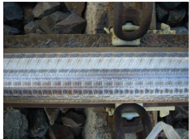
Rys. 4. Powierzchnia toczonej szyny po szlifowaniu [fot. autor]
