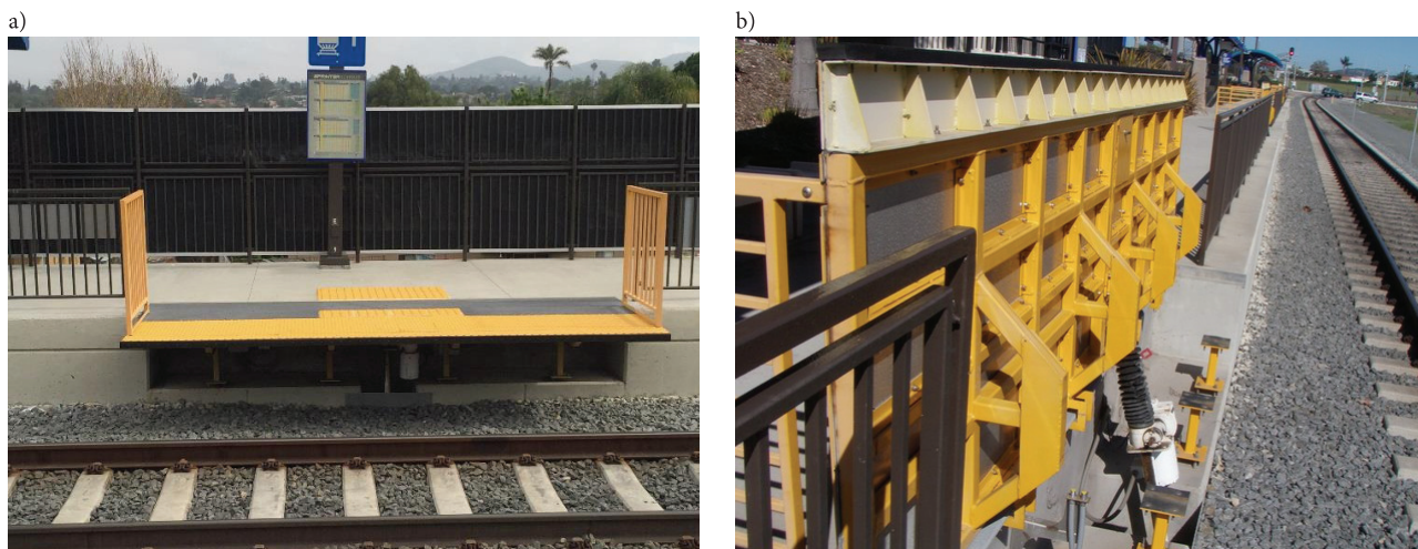
Rys. 12. Widok rozłożonej kładki (a) [4], kładka złożona (b) [20]
