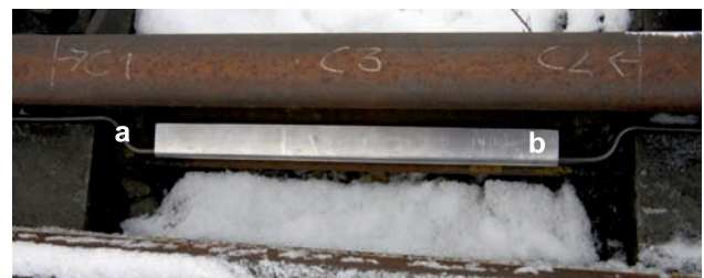
Rys. 5. Prototypowe grzejniki bezstykowe firmy TERMORAD: a) grzejnik bezstykowy, b) radiator [fot. D. Brodowski]
