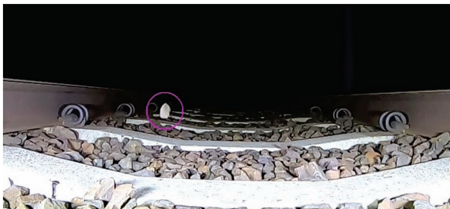
Rys. 10. Kamień poderwany pod pociągiem i lecący jeszcze po przejeździe pociągu [fot. A. Zbieć]
