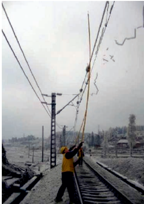
Rys. 2. Mechaniczne odładzanie sieci trakcyjnej za pomocą izolowanego drąga [2]
