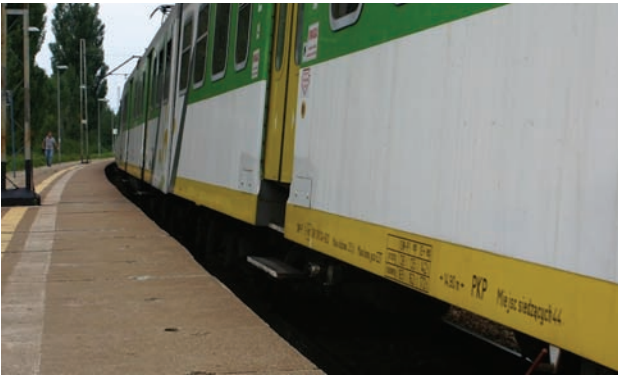
Rys. 3. Nieistniejący już peron na jednej ze stacji na Mazowszu z wyraźnie oddaloną krawędzią peronu od pociągu [fot. G. Stencel]
