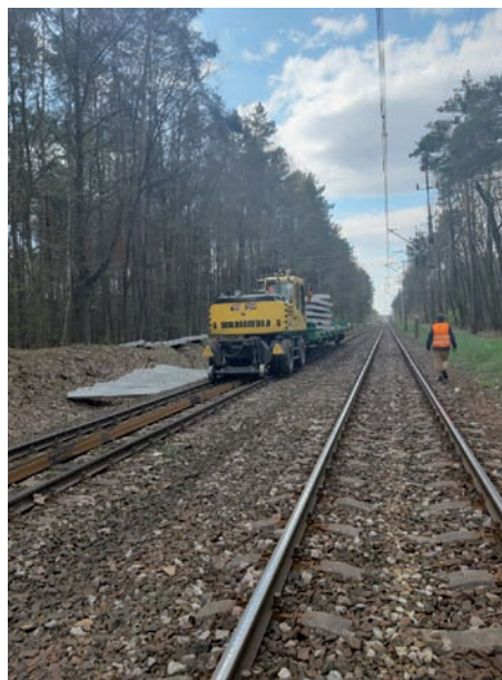
Fig. 18. Maintenance work on LK 68 Nowa Sarzyna – Leżajsk (5 May 2023) [photo: PLK]
