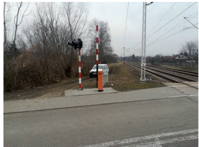
Fig. 19. The new Przemyśl Wschodni stop construction site (1 April 2023) [photo: Ł. Fronc / PLK]
