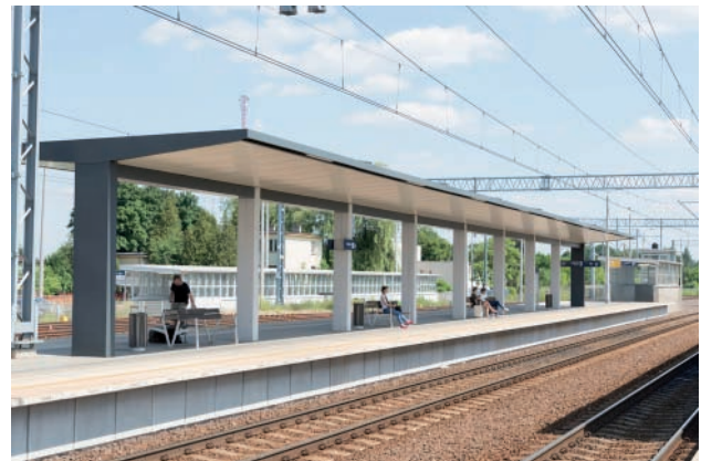
Rys. 8. Stacja w Dęblinie po modernizacji [fot. G. Biega / PLK]
