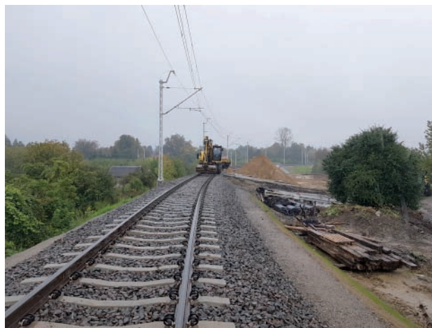
Rys. 9. Budowa łącznicy (LK 588) w Lublinie [fot. M. Tyburk / PLK]
