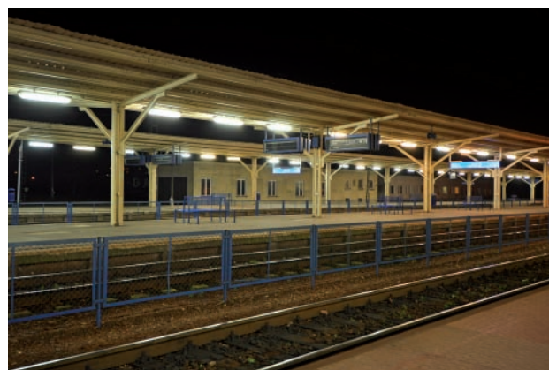
Rys. 5. Stacja w Lublinie przed modernizacją (25.10.2014 r.) [fot. M. Graff]
