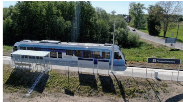
Fig. 19. Parczew Kolejowa train stop and SA103-012 [photo by A. Lewandowski, P. Mieszkowski/PLK]
