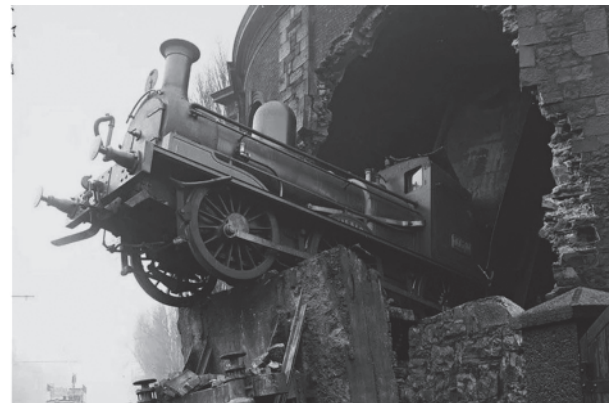
Rys. 2. Wykolejenie pociągu na stacji w Dublinie Irlandia, 1900 r.; widoczny fragment urządzenia kończącego tor kolejowy znajduje się pod lokomotywą; Biblioteka Narodowa Irlandii [8]
