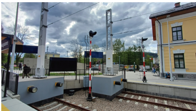
Rys. 5. Stacja Zakopane – stacja krańcowa, obecne rozwiązanie w zakresie zakończenia torów (17.05.2024 r.) [fot. W. Kowalczyk]
