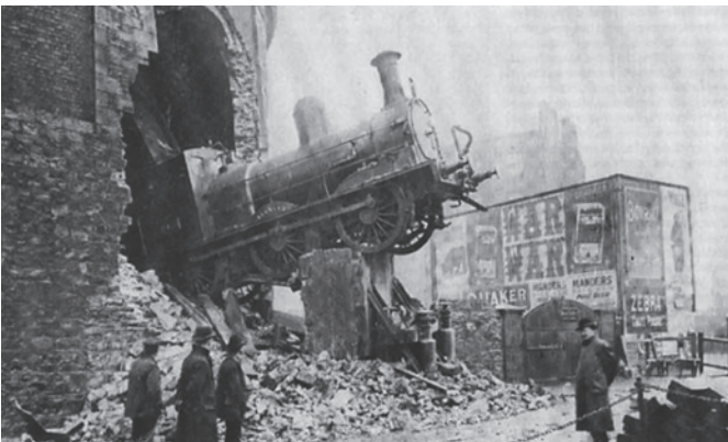
Rys. 2. Wykolejenie pociągu na stacji w Dublinie Irlandia, 1900 r.; widoczny fragment urządzenia kończącego tor kolejowy znajduje się pod lokomotywą; Biblioteka Narodowa Irlandii [8]
