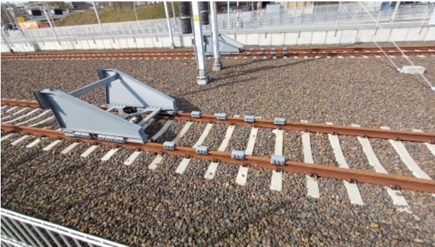
Rys. 10. Kocioł oporowy samohamowny – stacja Warszawa Główna [fot. W. Kowalczyk]
