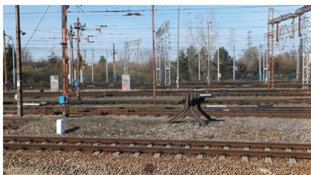
Rys. 8. Kozły oporowe stałe (nieprzesuwne) – konstrukcje według normy BN-79 9310-06 na stacji Warszawa Grochów [fot. D. Kowalczyk]
