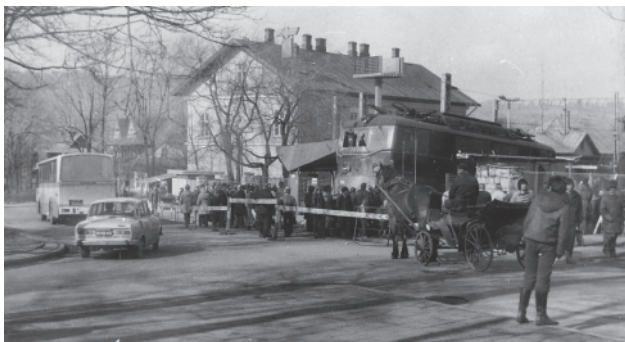
Rys. 4. Wykolejenie pociągu na stacji Zakopane (23.03.1979 r.); lokomotywa nie wyhamowała w torach stacji, zniszczyła kozioł oporowy i wyjechała na ulicę Kościuszki [7]
