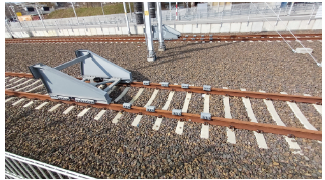
Fig. 10. Sliding buffer stop – Warszawa Główna Station [photo by W. Kowalczyk]
