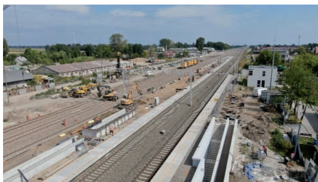
Rys. 5. Stacja Szepietowo na LK 6 (km 127,376) podczas modernizacji [fot. A. Lewandowski / PLK]
