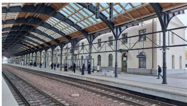
Rys. 8. Nowa hala peronowa na dworcu głównym w Białymstoku (6.04.2024 r.) [fot. Rakoon / Wikimedia Commons]
