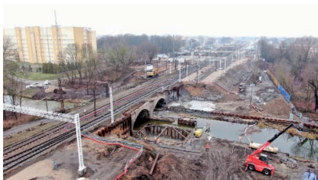
Rys. 12. Budowa mostu nad rzeką Ełk [fot. P. Chamera / PLK]
