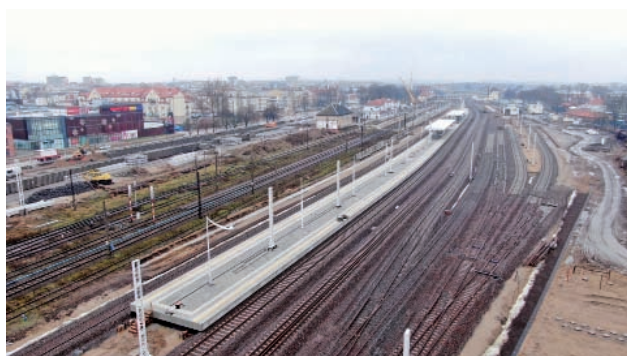
Rys. 11. Stacja Ełk podczas modernizacji [fot. D. Strzemkowski / PLK]
