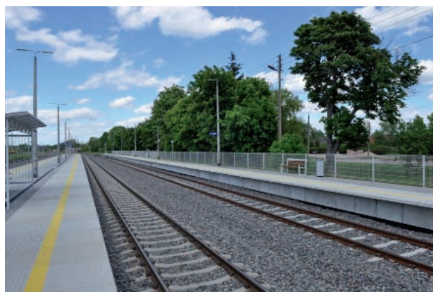
Rys. 14. Stacja Czeremcha po modernizacji (6.06.2020 r.) [fot. M. Graff]
