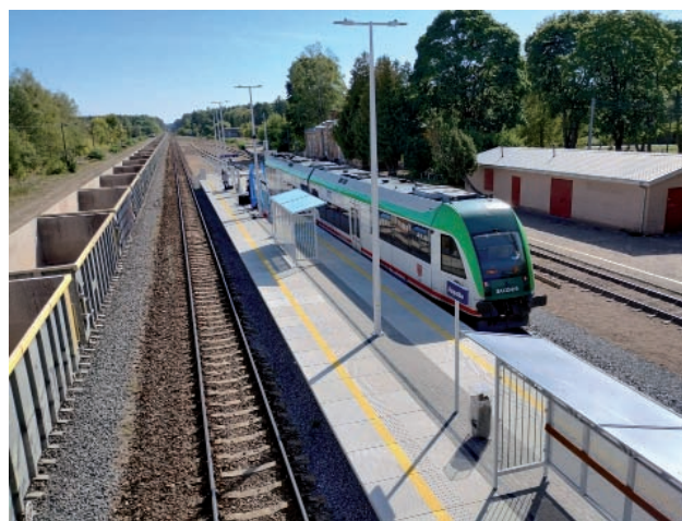
Rys. 13. Stacja Augustów po modernizacji [fot. T. Lotowski / PLK]
