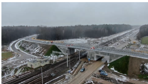
Rys. 6. Stacja Racibory na LK 6 (km 140,474) podczas modernizacji [fot. Artur Lewandowski]
