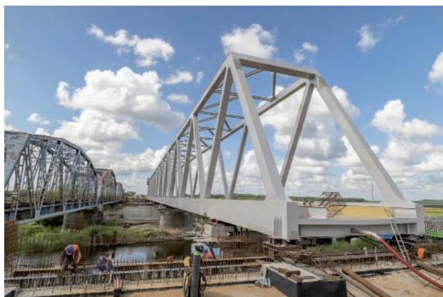
Rys. 7. Uhowo na LK 6 (km 156,265), budowa nowego mostu nad Narwią [fot. Ł. Brylowski]
