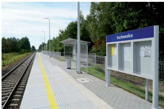
Rys. 20. Przystanek Suchowolce na LK 32 (km 13,007) po modernizacji [fot. T. Lotowski / PLK]
