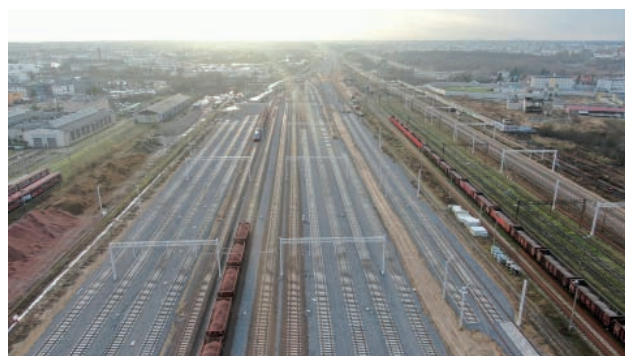
Rys. 3. Stacja Białystok podczas modernizacji – nowy układ torowy [fot. A. Lewandowski / PLK]
