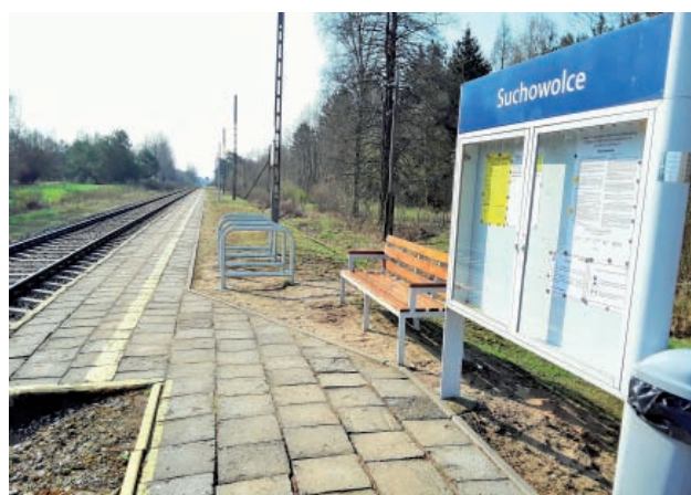
Rys. 19. Przystanek Suchowolce na LK 32 (km 13,007) przed modernizacją (21.04.2021 r.) [fot. E. Lewkowicz / PLK]
