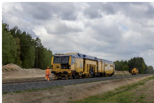
Rys. 26. Podbijarka torowa na szlaku Jastrzębka – Parciaki na LK 35 [fot. Ł. Bryłowski / PLK]
