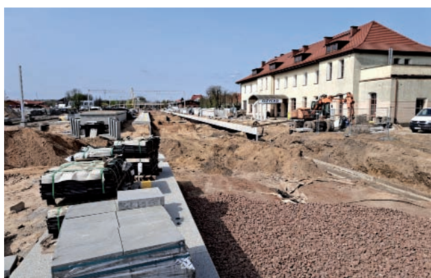
Rys. 19. Stacja kolejowa w Giżycku w trakcie modernizacji [fot. M. Dziewiecin / PLK]
