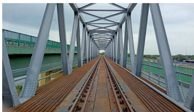
Rys. 28. Most kolejowy w Elblągu na LK 254 [fot. A. Puzewicz / PLK]
