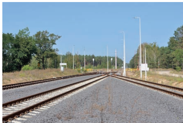
Rys. 25. Stacja kolejowa w Chorzelach, widok w kierunku Szczytna na LK 35 (24.09.2024 r.) [fot. M. Graff]
