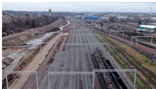
Rys. 13. Stacja Olsztyn Główny Olsztyn podczas modernizacji (styczeń 2023 r.) [fot. A. Puzewicz / PLK]
