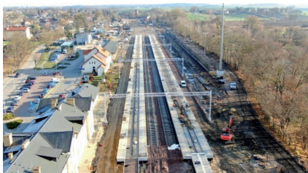
Rys. 20. Stacja kolejowa w Kętrzynie w trakcie modernizacji [fot. D. Strzemkowski / PLK]
