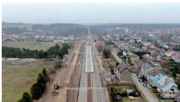
Rys. 21. Stare Juchy na LK 38 w trakcie modernizacji [fot. D. Strzemkowski / PLK]
