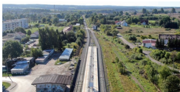
Rys. 24. LK 223 Stacja Dobrze Miasto na LK 221 podczas modernizacji [fot. D. Strzemkowski / PLK]
