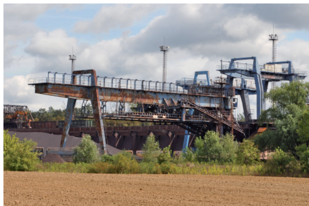
Rys. 21. Stanowisko do rozładunku grawitacyjnego rudy żelaza na stacji Eperjeske alsó, Węgry (4.09.2022 r.) [fot. M. Graff]
