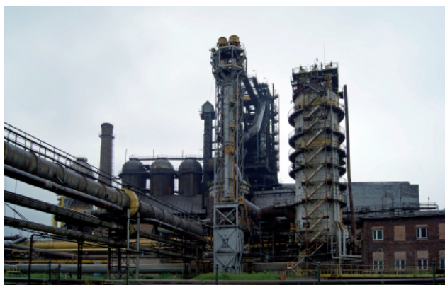
Rys. 6. Wielki piec na terenie huty żelaza im. T. Sendzimira, obecnie nieistniejący, Nowa Huta, Kraków / ArcelorMittal Kraków (16.07.2011 r.) [Z. Put / Wikimedia Commons]
