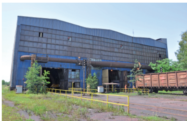
Rys. 17. Węglarka serii 12-753 (1520 mm) przygotowana do rozładunku rudy żelaza na wywrotnicy w Bazie Przeładunku Rud Huty Katowice, Dąbrowa Górnicza / ArcelorMittal Poland (25.06.2016 r.) [fot. M. Graff]
