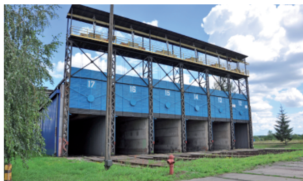
Rys. 13. Rozmrażalnia rudy żelaza na stacji Medyka (28.07.2015 r.) [fot. M. Graff]
