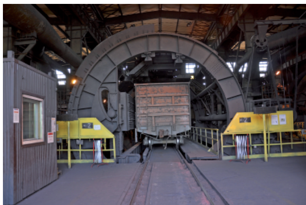
Rys. 18. Hala wyposażona w wywrotnice do rozładunku rudy żelaza na terenie Bazy Przeładunku Rud Huty Katowice, Dąbrowa Górnicza / ArcelorMittal Poland (25.06.2016 r.) [fot. M. Graff]
